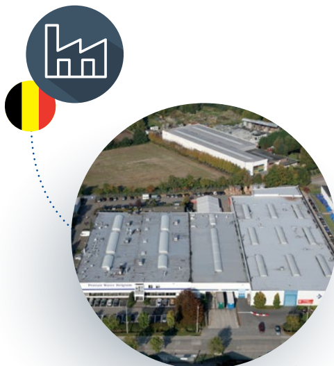
Site de production de Structural Herentals, Belgique
